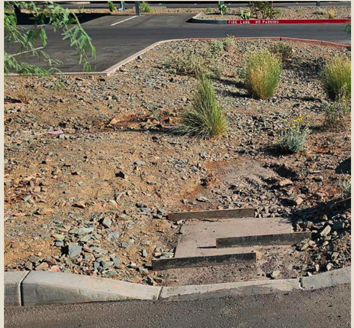
Curb cut and mini check dam.
