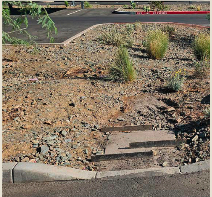
Curb cut and mini check dam.
